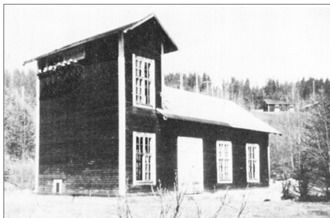
Petiknäs kraftstation. Foto: Ivar Hellder
